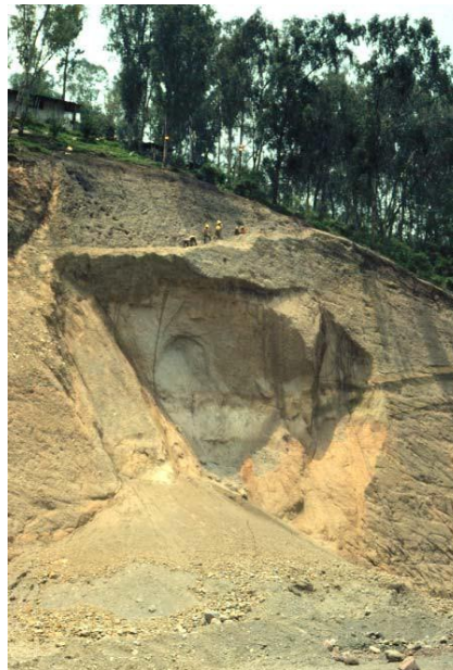
Fig 15 Falla de una cuña en un corte artificial en tobas (Santa Fé)
