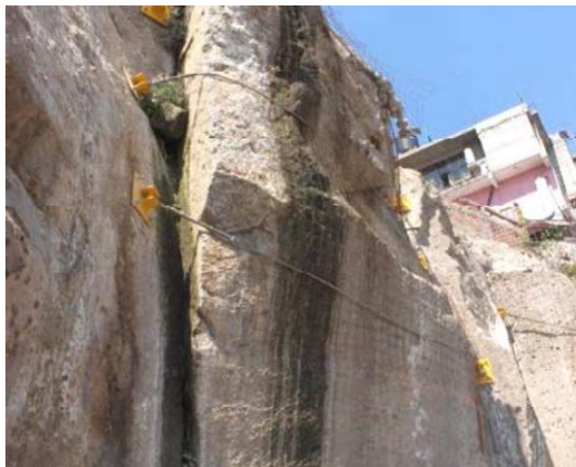
Fig 20 Estabilización de bloques inestables (Jiménez, 2007)
