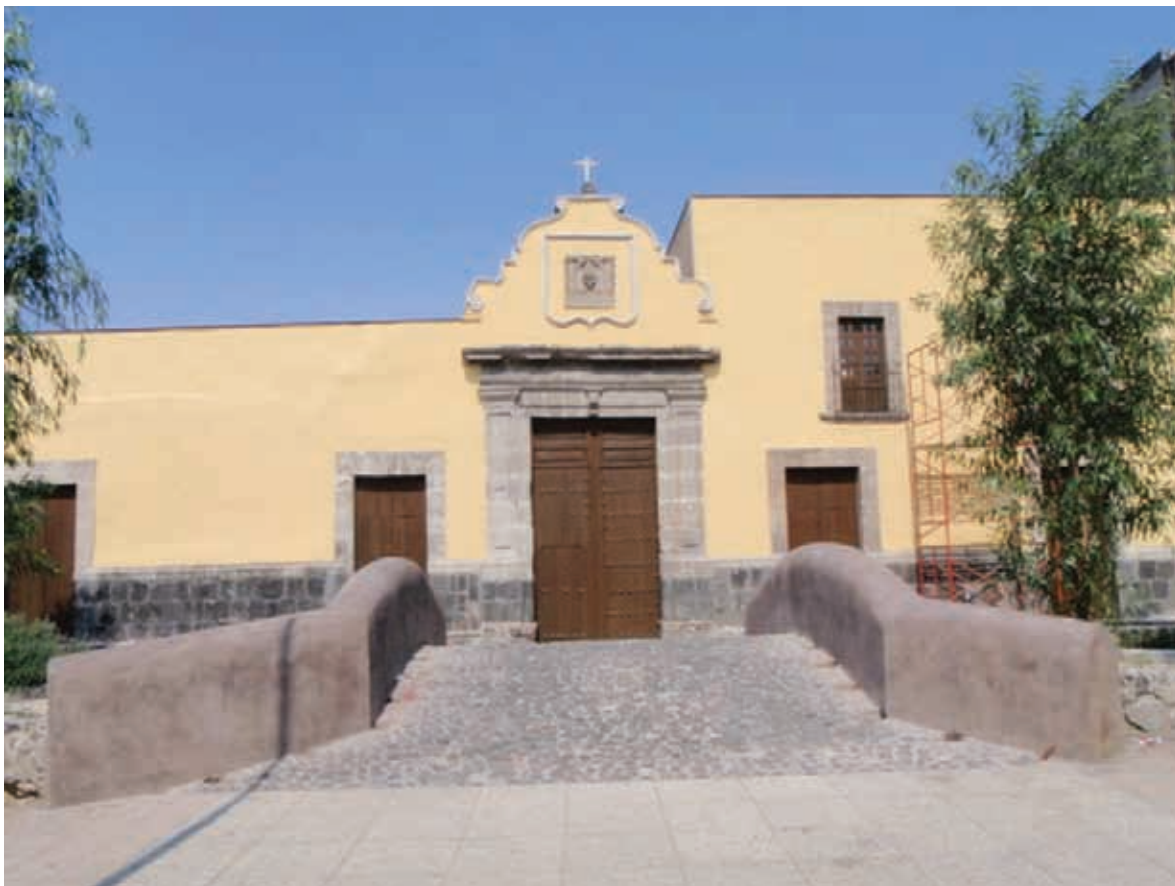
Dos imágenes diferentes que nos muestran las modificaciones y la actualidad de la Casa del Diezmo y el Puente de Roldán.
