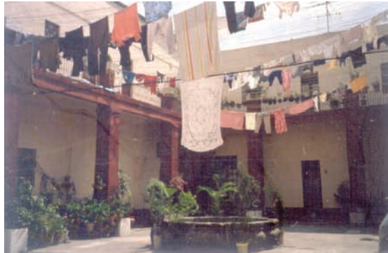
Casa de la Covadonga antes de su rehabilitación
