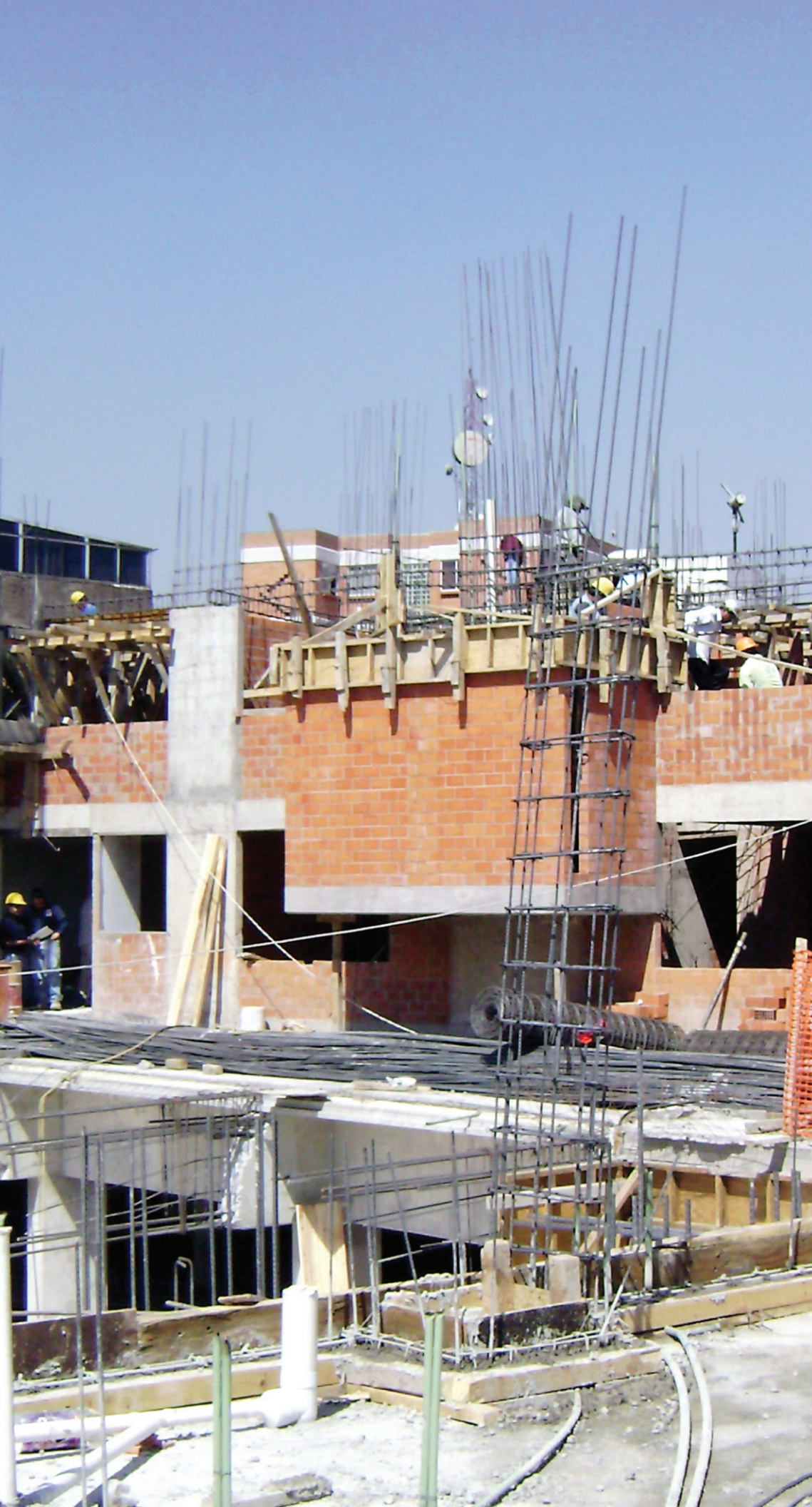
Conjunto habitacional en construcción, México, D.F.
