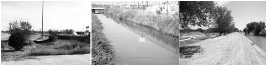
Foto 4. Imágenes del estado de los espacios destinados a áreas verdes y el canal abierto de aguas negras
