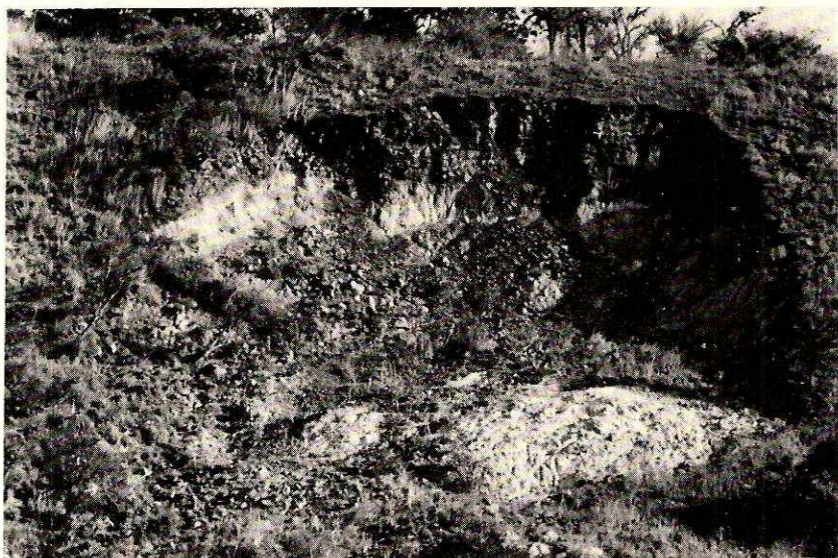
Foto 1. Deslizamiento rotacional, (cortesía de M. A. Ortiz).
